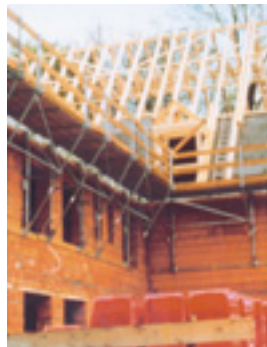
04 Ικρίωμα με υποστηλώματα
