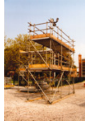
02 Ικρίωμα από συνδεδεμένους χαλύβδινους σωλήνες
