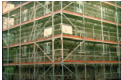
01 Διαμόρφωση συστημάτων ικριωμάτων (συστήματα ικριωμάτων)
